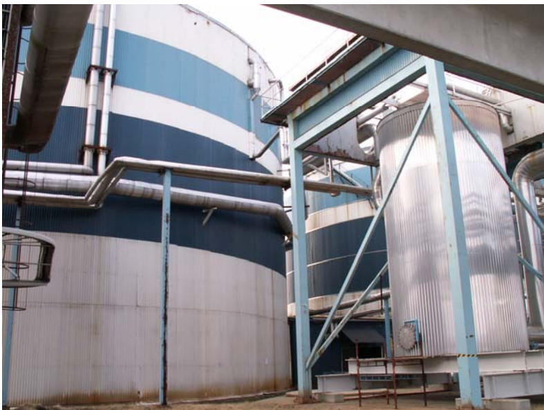
Figur 1 Biogasanläggningen i Domsjö. De blå och vita tankarna är anaeroba tankar och den blanka är en avgasningstank mellan anaerobin och sedimenteringsbassängen
