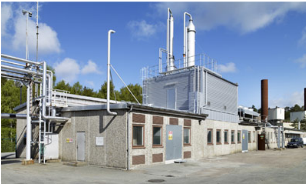
Figur 1 Uppgraderingsanläggningen i Arendal
